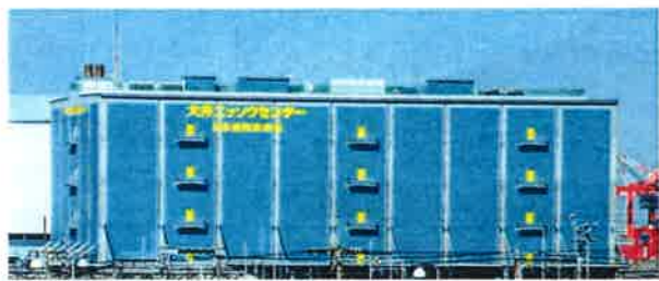
大井ニッソウセンター (東京貨物ターミナル駅構内)
